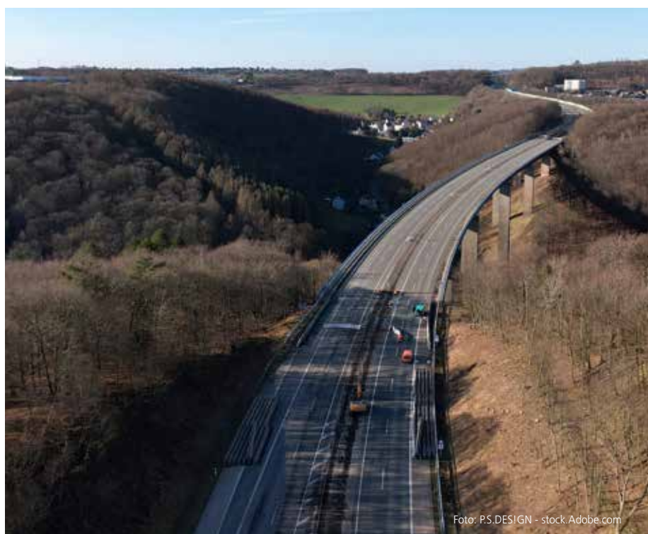
Die gesperrte Rahmedebrücke auf der A 45.
